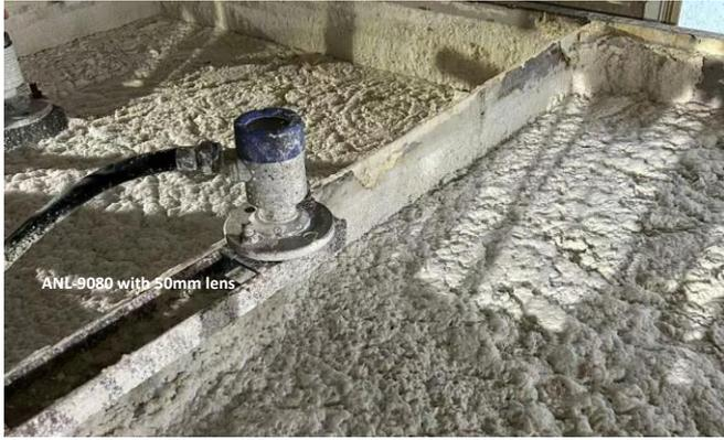
Note: 对于这种厚泡沫测量应用，带有小透镜（50 mm）的 80 GHz 物位雷达不是最佳的产品选型，这通常会导致测量不稳定和电平跳跃。建议使用直径至少为 80 毫米的透镜天线的 80 GHz 雷达会更具有优势。
